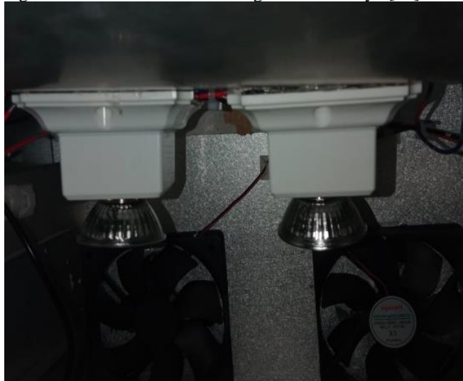
Gambar 13 Pemasangan Lampu Bohlam
