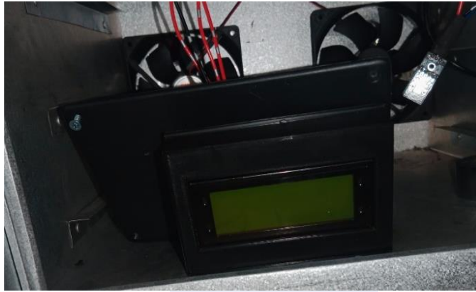
Gambar 10 Pemasangan Pilot Lamp
