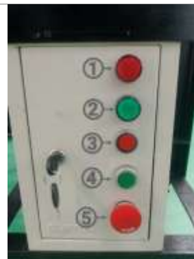
Gambar 6. Bagian luar panel box
