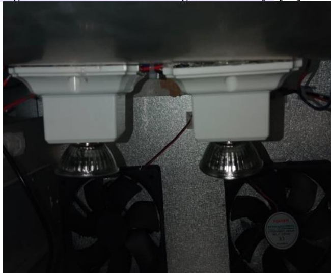
Gambar 13 Pemasangan Lampu Bohlam
