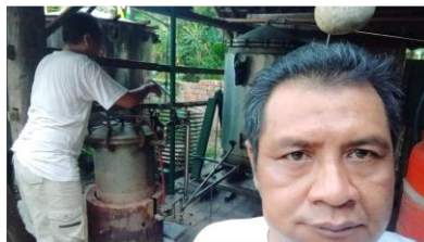
Gambar 8. Pengisian air pada boiler dan penyalaan tungku.
