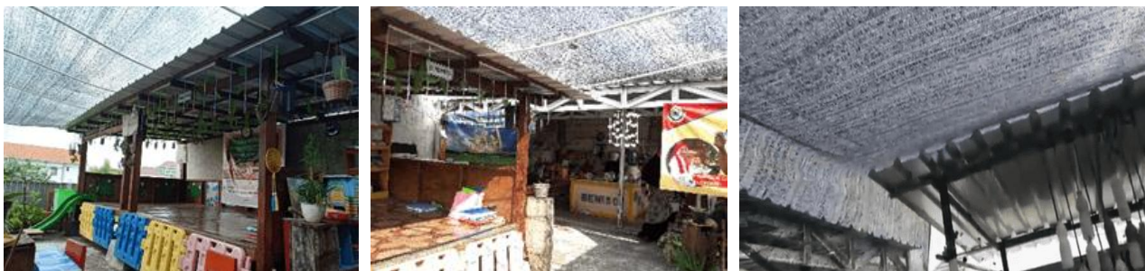
Gambar 3. Hasil perbaikan konstruksi gazebo dan sekitarnya.
