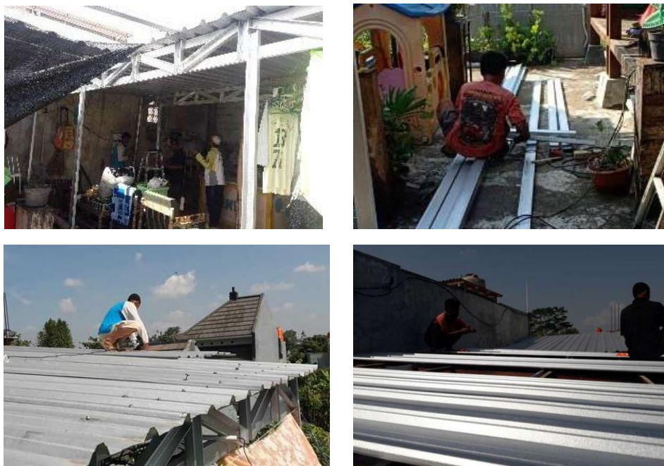
Gambar 2. Proses perbaikan konstruksi.
