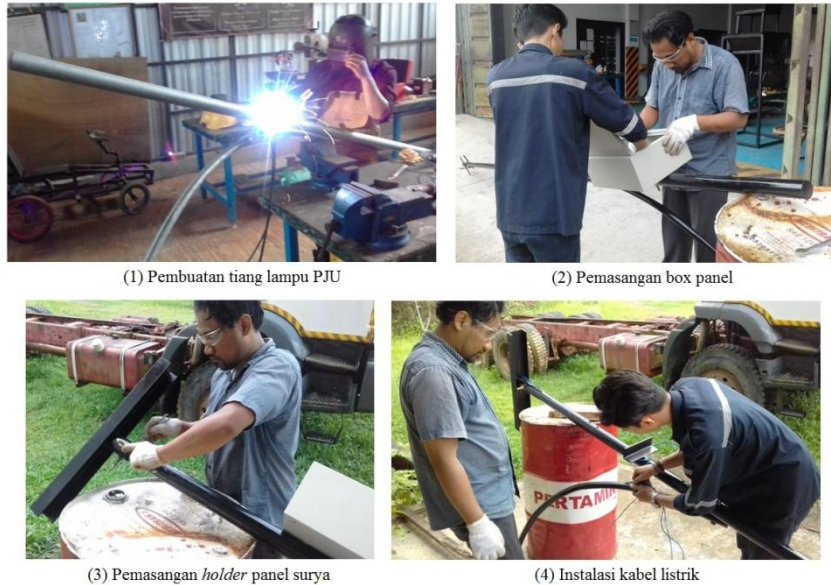
Gambar 4. Pembuatan dan perakitan awal lampu PJU berbasis solar system
