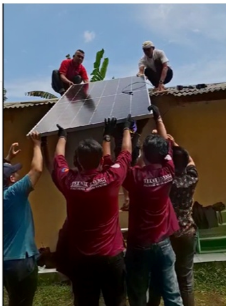
Gambar 2. Proses pemasangan PLTS Sekolah Alam
