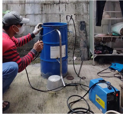
Gambar 3. Pembuatan Reaktor dan Sistem Kondensor
