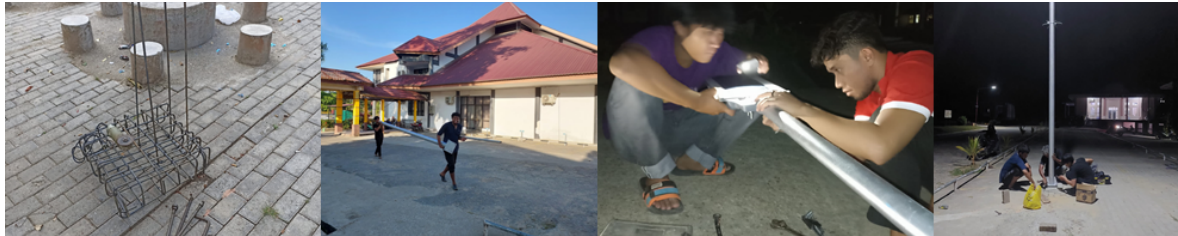
Gambar 2. Dokumentasi tahapan proses instalasi lampu jalan tenaga surya.
