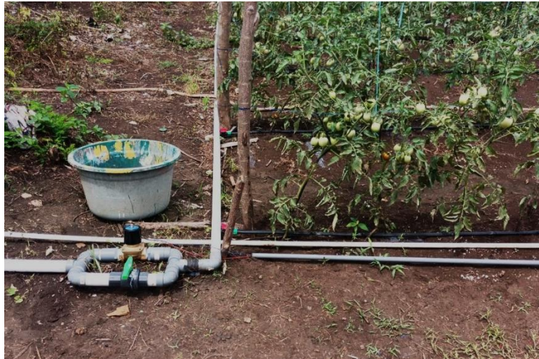
Gambar 6. Pemasangan otomatisasi pada pipa utama sistem irigasi tetes
