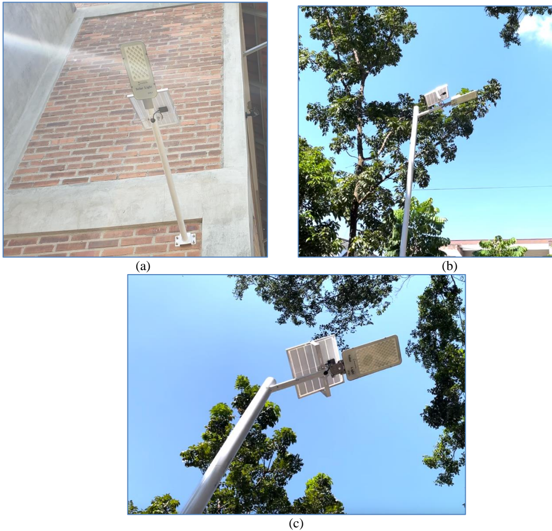
Gambar 2. Realisasi Pemasangan Lampu dan Panel Surya, (a) lokasi pertama, (b) lokasi kedua, dan (c) lokasi ketiga.
