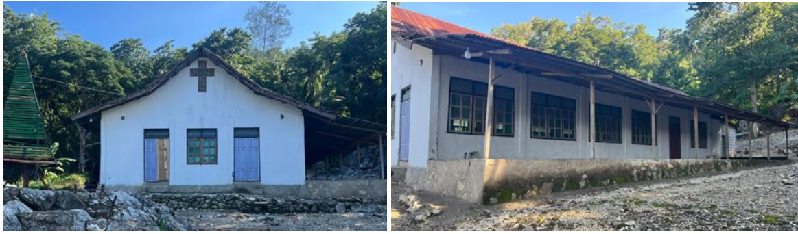
Gambar 3. Kondisi bangunan Gereja Bet'El di Desa Fatuat
