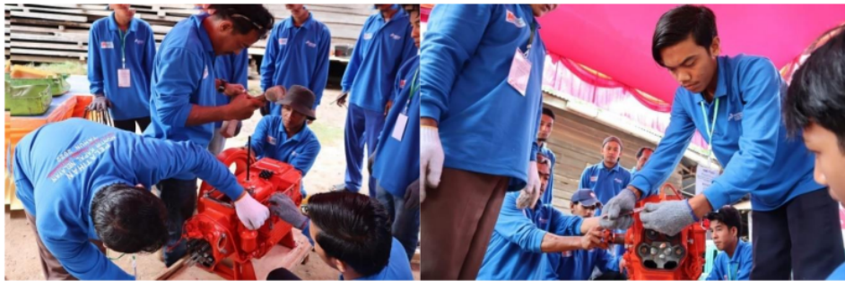
Gambar 2 foto kegiatan praktik perbaikan mesin penggerak kapal nelayan
