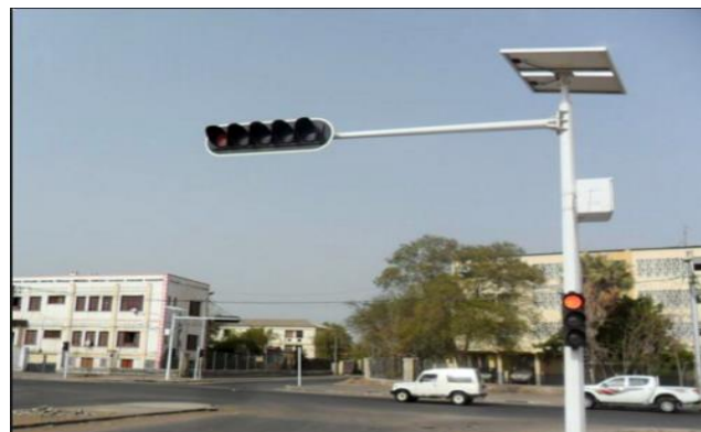
Gambar 2. Pemanfaatan solar cell sebagai sistem lalu lintas otomatis bertenaga surya (Sumber : Risma, 2016).
