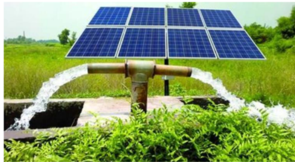
Gambar 6. Pemanfaatan solar cell pada mesin pompa listrik sebagai penyalur air (Sumber : Desapintar, 2021).
