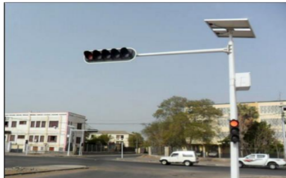
Gambar 2. Pemanfaatan solar cell sebagai sistem lalu lintas otomatis bertenaga surya (Sumber : Risma, 2016).
