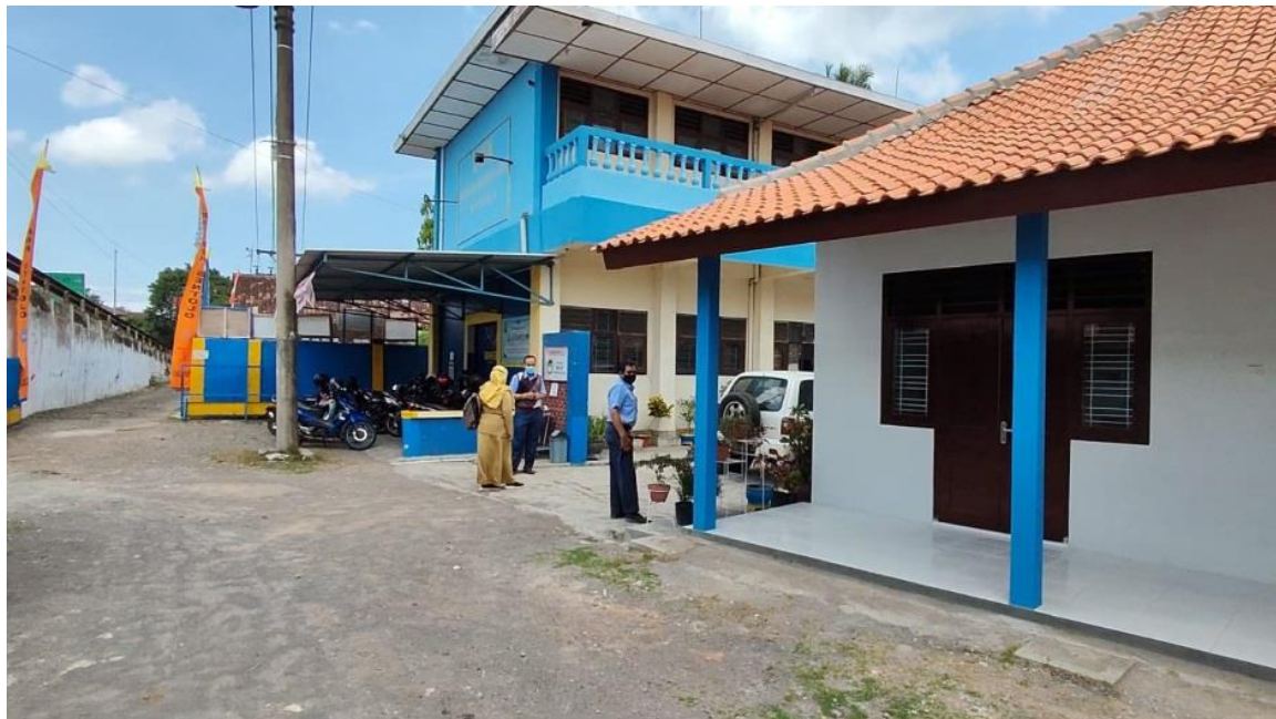
Gambar 1. Kondisi letak lokasi yang kurang menguntungkan
